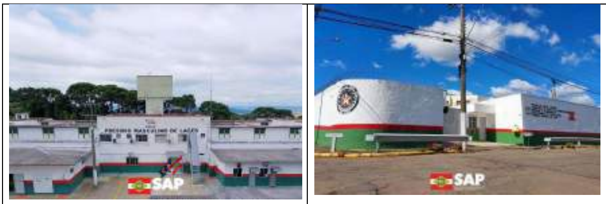
Figura 4 – Presídio Masculino de Lages e Presídio Regional de Lages
