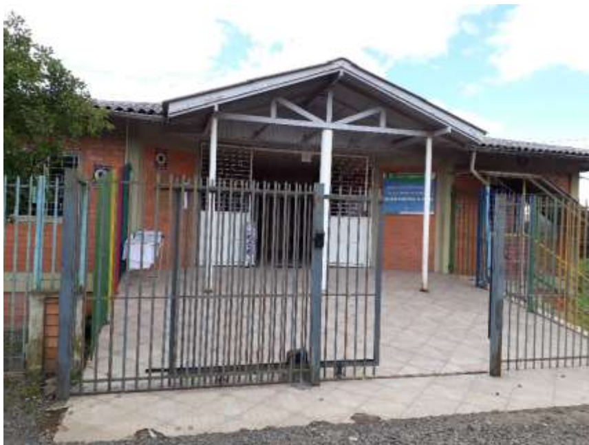
Fotografia 1- Fachada do Ceim Nelson Martins de Almeida, Lages/SC.
