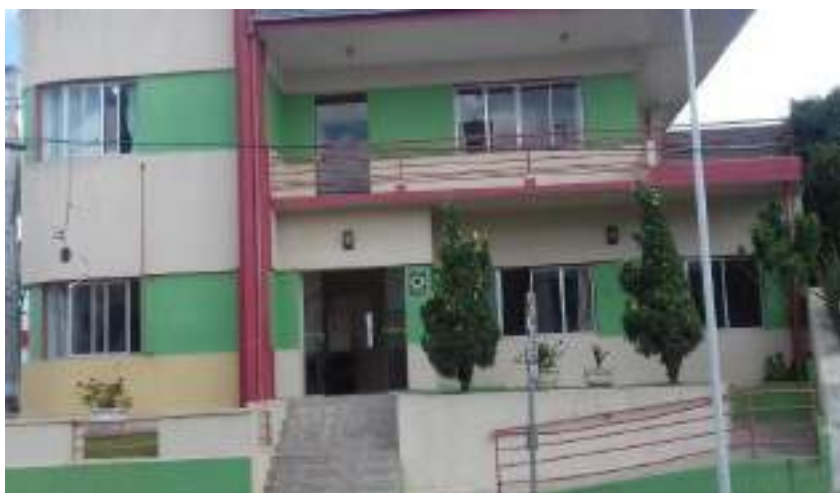
Figura 5 - Imagem do Prédio da EJA - Lages SC
