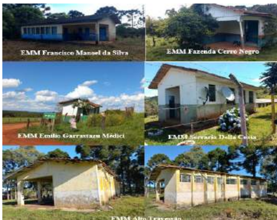
Figura 26 - Prédios de escolas multisseriadas extintas no interior do município de Campo Belo do Sul/SC
